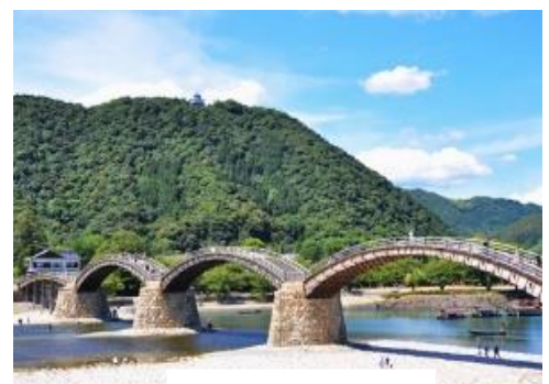
岩国市 錦帯橋
