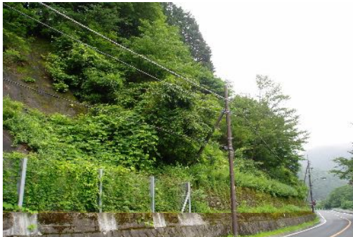
施工18年後（在来種による自然再生）
