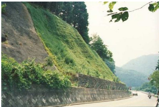
施工1年後（導入植物による植生）
