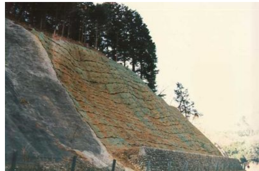
施工完了（マットによる法面保護）
