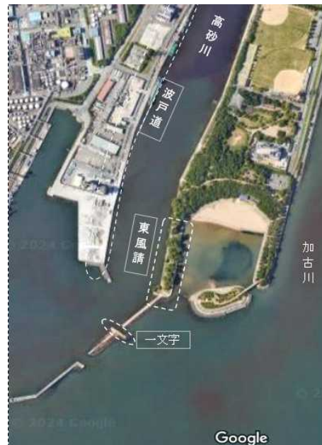
図 12-8 高砂港の現状航空写真
