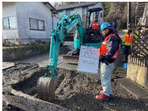
重機での 掘削状況
