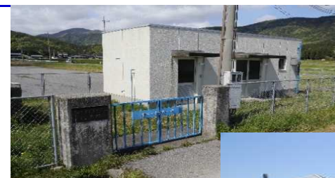
七尾高中 中継ポンプ場
