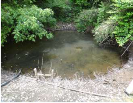
▲写真 2: 2 つ目のため池
