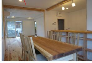
LDK床はカーペットから30mm厚の無垢板に改修。内窓を設置し、2重サッシにすることにより断熱性も向上し結露がなくなりました。
