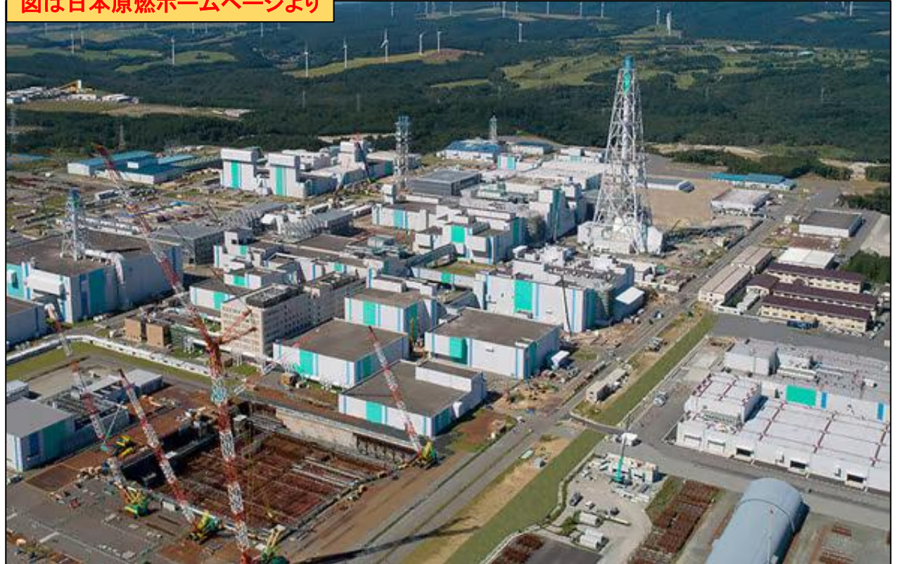
図は日本原燃ホームページより
