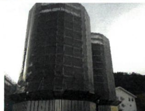
(旧タンクの仮置き状況)
