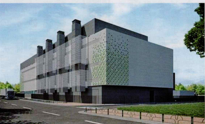
データセンター
