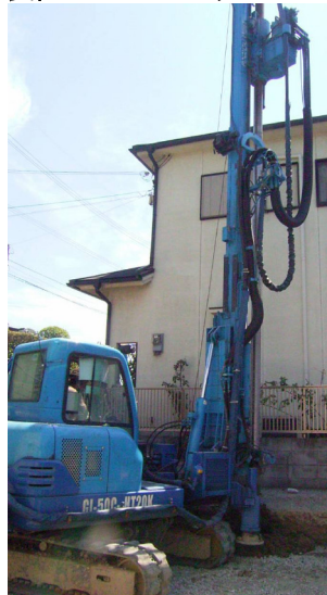
記録装置付きクローラー式リーダーマシン
