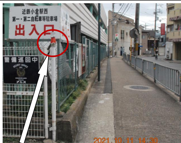
1 小倉西：出入口にパテライト設置
