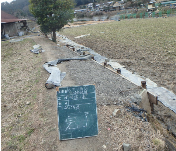
屋外作業班 田んぼ水路の護岸用壁工事で本領
