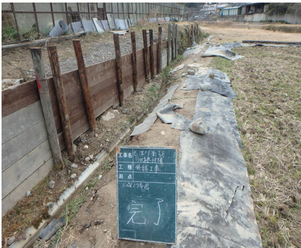
屋外作業班 田んぼ水路の護岸用壁工事で本領 発揮！ 高い評価を得ています
