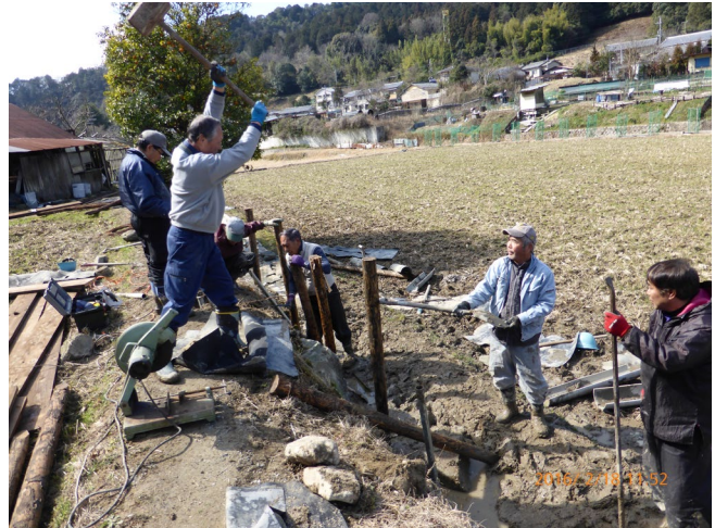
屋外作業班 田んぼ水路の護岸用壁工事で本領発揮！ 高い評価を得ています
