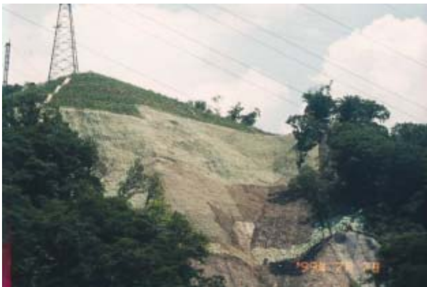
植生基盤材注入状況
