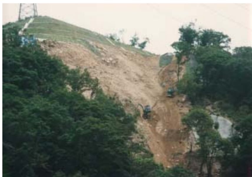
法面清掃状況
