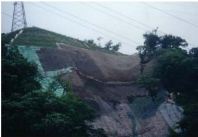
植生マット布設状況
