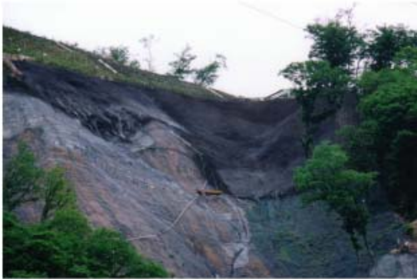
基礎工(客土吹付状況)
