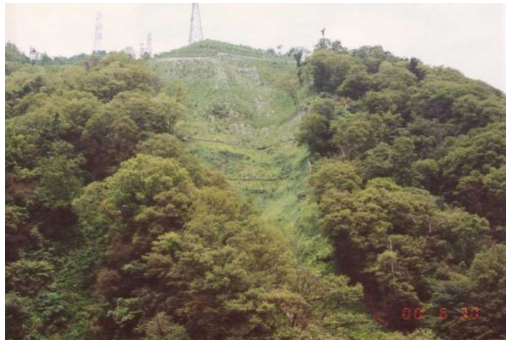
植生状況(施工1年後)
