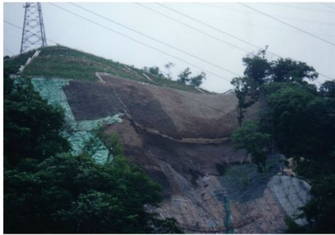
基盤材注入(圧送)状況
