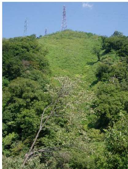
植生状況(施工2年後)
