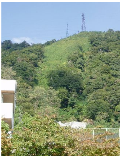
植生状況(施工4年後)
