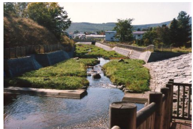
植生状況(施工1年後)
