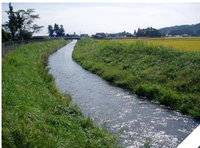
植生状況(施工4ヵ月後)
