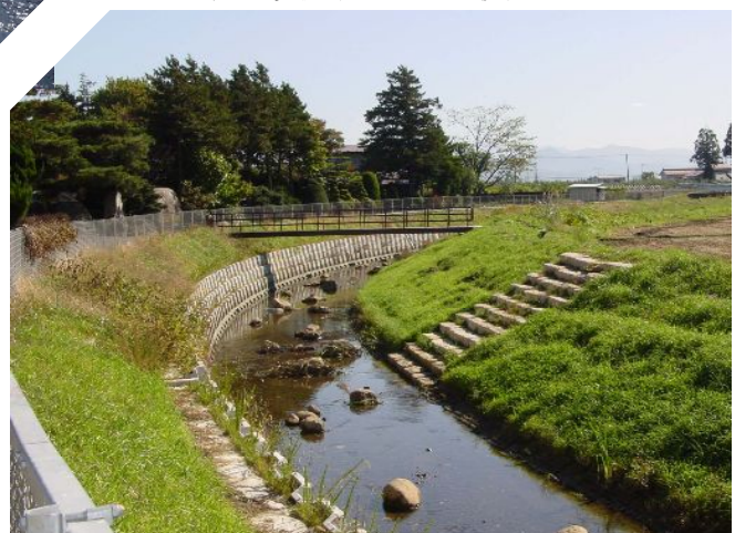
植生状況(施工8ヵ月後)
