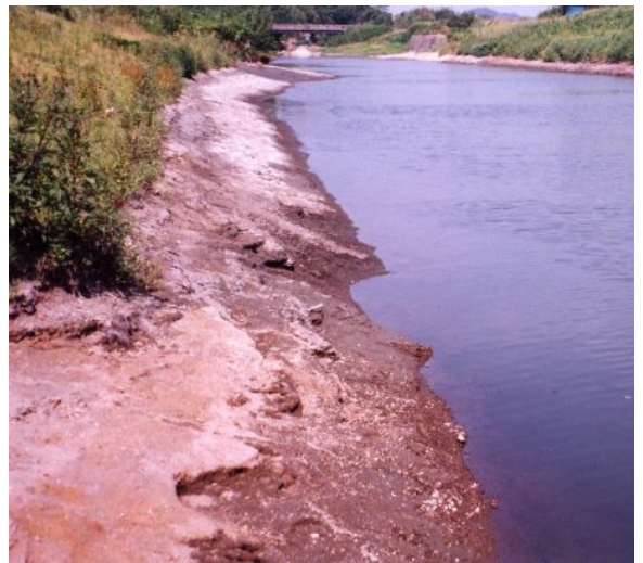
施工箇所の地山の状況
