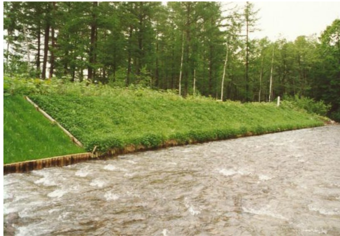
植生状況(施工後6ヶ月)
