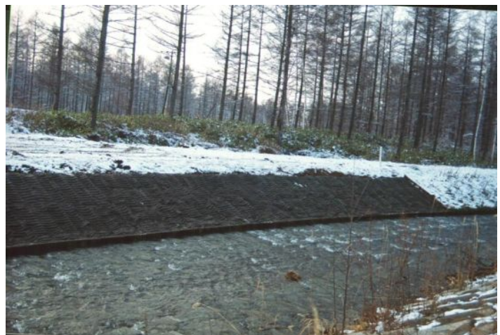
基盤材注入完了
