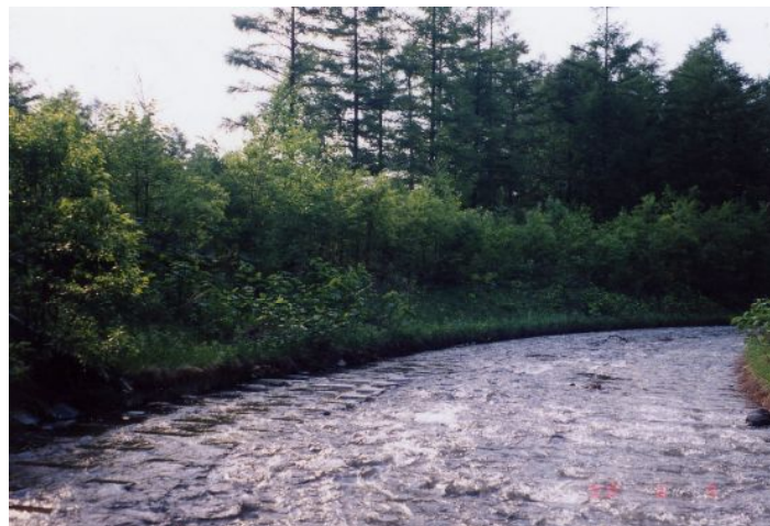
植生状況(施工後1年)
