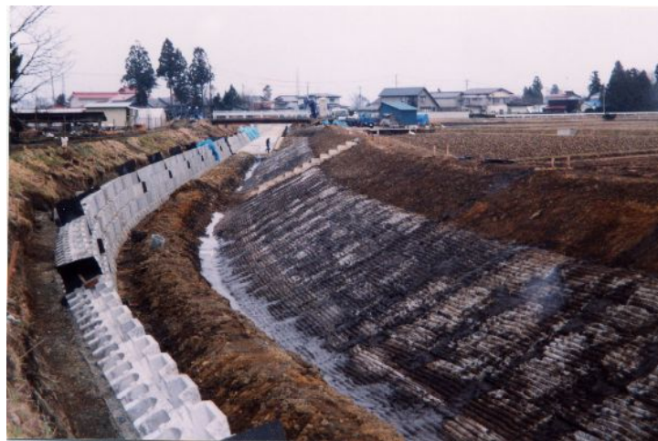
施工完了(平成12年2月)
