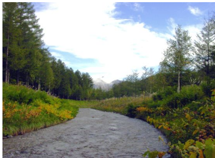
植生状況(施工後9年)
