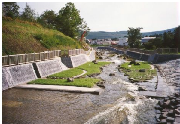
植生状況(施工3ヶ月)
