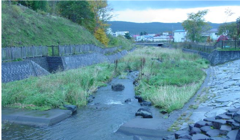
植生状況(施工6年後)
