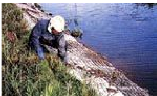
生育基盤材注入状況
