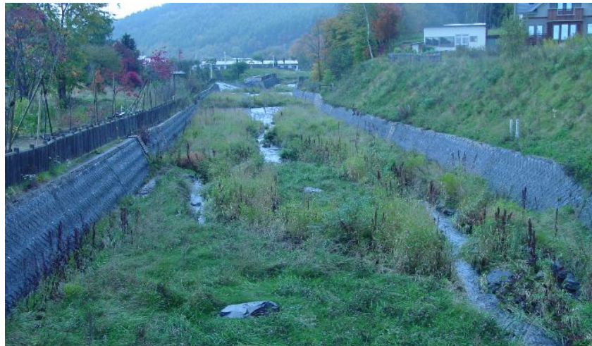
植生状況(施工6年後)
