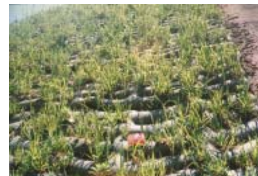
基盤吹付あり
