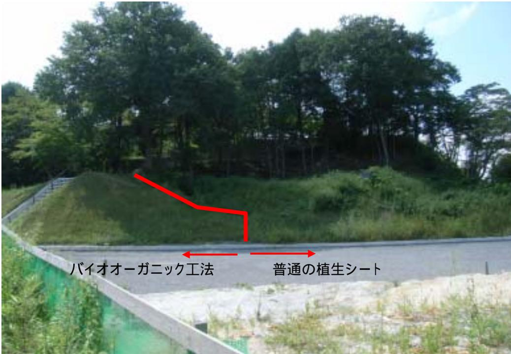
バイオオーガニック工法と、普通の植生シートとの比較写真です。バイオの方は余計な植物はあまり生えずきれいな法面になっています。
