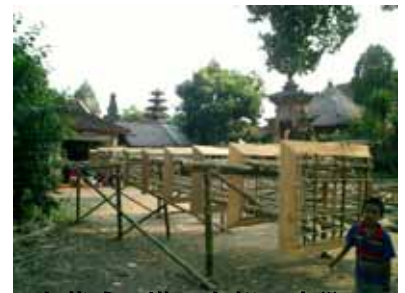
火葬式の塔の上部の建設
