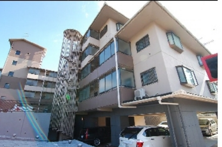
エクセルコート室積池
