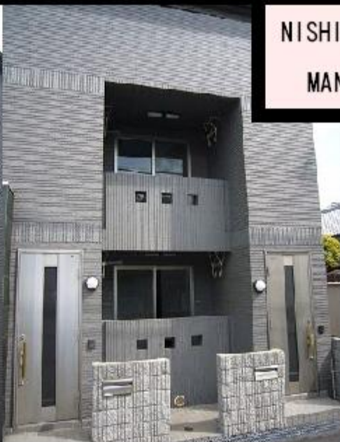
玄関扉(1F・2F)
