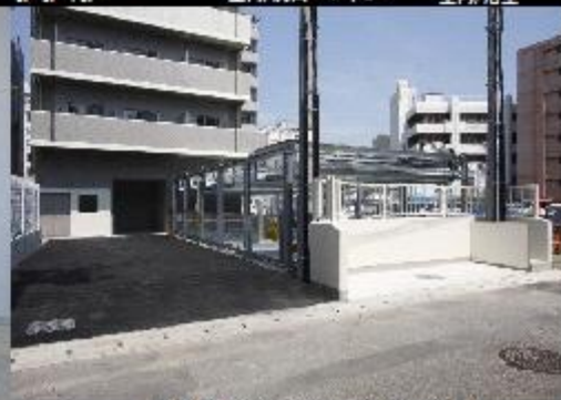
駐輪/原付出入口・ガレージ・ごみ置場
