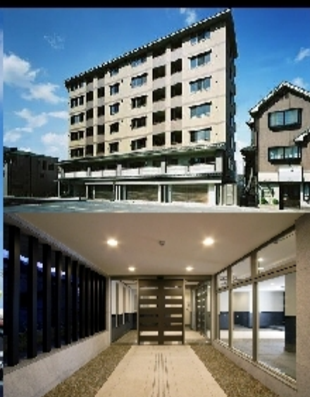
建物全貌/エントランス
