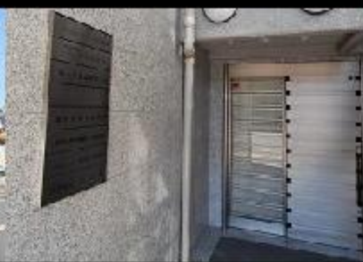
事務所側エントランス
