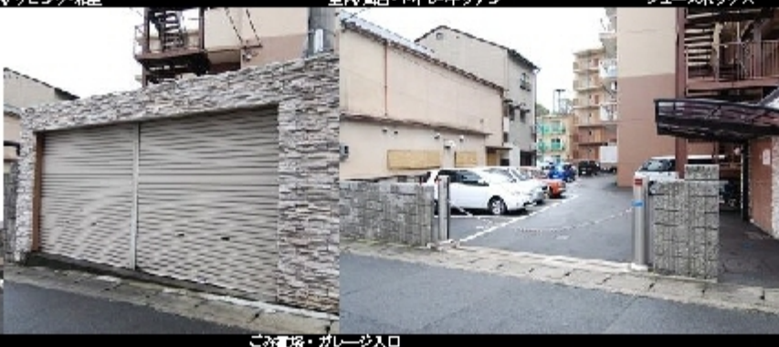
ごみ置場・ガレージ入口
