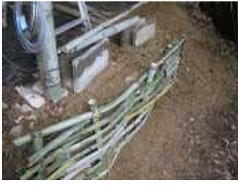
(山田川の暫定護岸に使われていた柵を盛土法面を補強)
