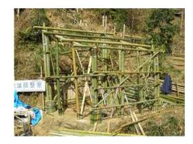
12.割り竹による屋根 平成21年2月25日 屋根は、割り竹を凹凸(上向き下向き)交互に重ね て番線で繋ぎ、横幅50cm位にした物を並べた。 竹の太さの不揃いと結束の技術不足で、雨水はとても 遮断できない。工夫が必要だ。
