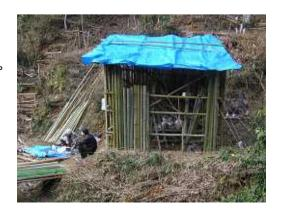
15. 小屋の概成(入口側) 平成21年2月28日 左側面に入口、右側面に出口を設けるが、 その時には、梁を付け替えることになる。
