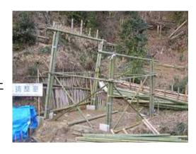
10.柱・梁・屋根の骨格 平成21年2月12日 屋根の梁も含めて、四角に組み終わると一応安定し、 接合箇所の再結束と筋交いの最終固定をした。
