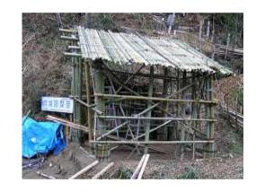
13.屋根シート掛け 平成21年2月27日 雨除けにビニールシートを被せることにした。 風で飛ばないようにさらに固定作業が必要である。
