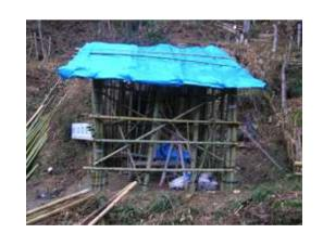
14.小屋の概成(正面) 平成21年2月28日 壁に丸竹や割り竹を縦に並べた。 正面には窓の設置を予定している。 右前方にワイヤーロープで、柱の傾きを防止している。 他の柱も引張りロープで補強しておきたい。
