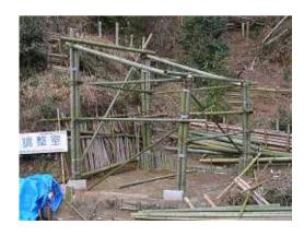
1 1 . 間柱による補強 平成 2 1年 2 月 1 8 日 地震や風に備えて、柱の間に間柱、筋交いの増強、 四隅の柱の下部に割り竹による根巻きを施した。 上の方の作業は、足場支保工でなく、二つの脚立や、 直交する梁に載せた板に上がって行ったが、複数の 人数で安全を確認しつつ行い事故なく終えた。
