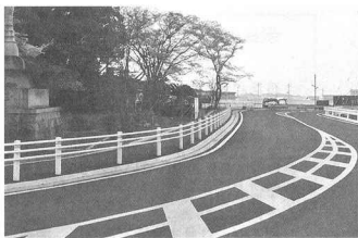
拡幅された市道(古市町)
