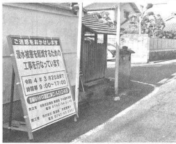
下水道工事が始まる(川久保町付近)
