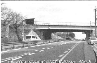
耐震対策予定の阪奈道路無名橋001(中町)
