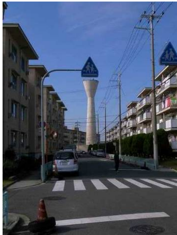
その白いお姿は？団地のシンボル、 給水塔です。くびれがセクシー☆
