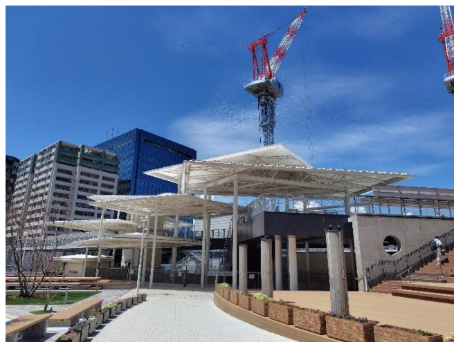
箕面船場阪大前駅「エントランス空間」8枚屋根の道路施設
