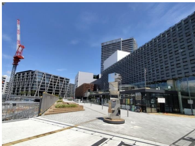
箕面船場阪大前地区複合公共施設 右手前に、文化芸能劇場 右手奥に、船場図書館と船場生涯学習センター 左手奥に、大阪大学箕面キャンパス
