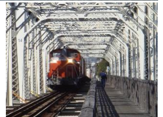
2009.11 赤川仮橋（単線十人道）→
