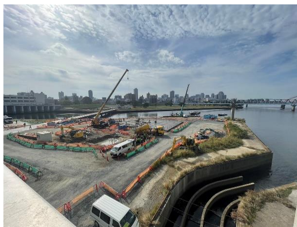
淀川閘門整備工事の様子（下流側）、右下は魚道
