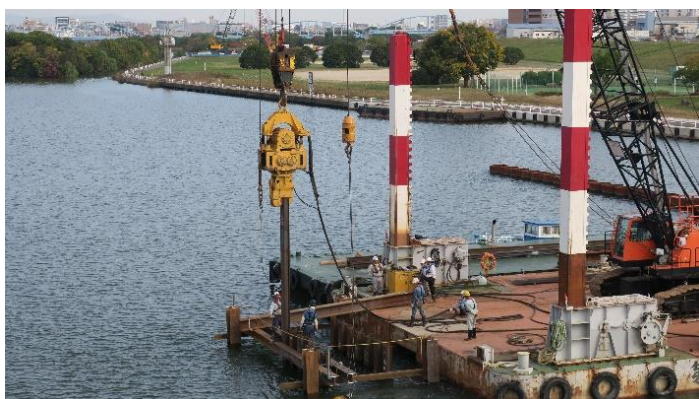
くい打ち作業中（上流側）
