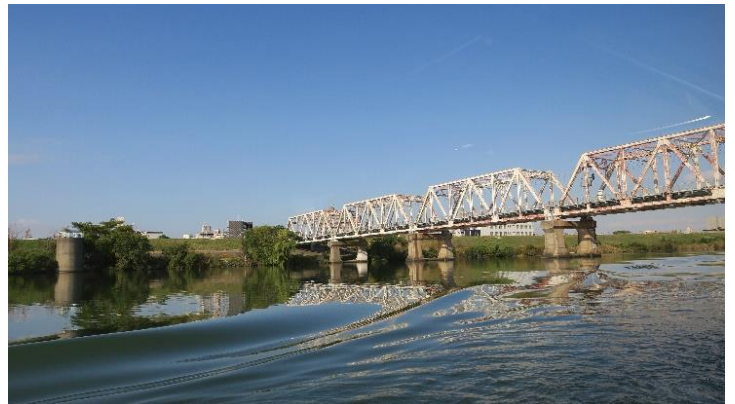
赤川鉄橋（JRおおさか東線） 通過した淀川橋梁の中で現役最長老 1,929（昭和4）年完成 もうすぐ100年 橋長610m、18連のトラス橋
