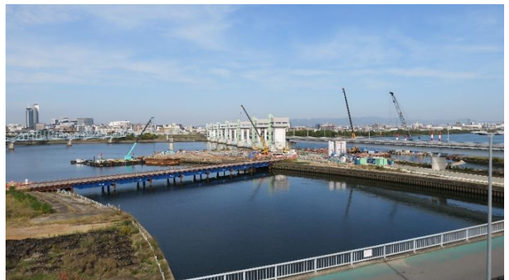
淀川大堰の全景
