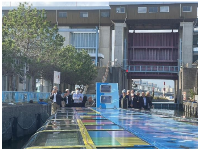
毛馬閘門を通過するアクアライナー 船尾から水位調整を体験しています (閘室 11.35m×107.0m)
