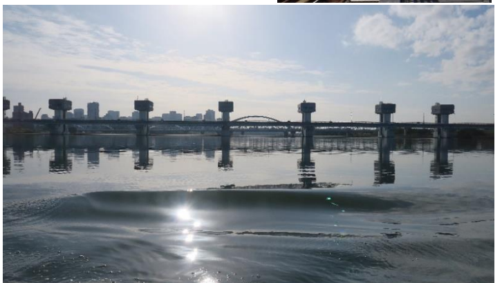
淀川大堰（上流側から） 可動部 全長330.0m 主ゲート 1枚扉4門 径間55.0m 扉高7.8m 調節ゲート 2枚扉2門 径間40.0m 扉高7.8m
