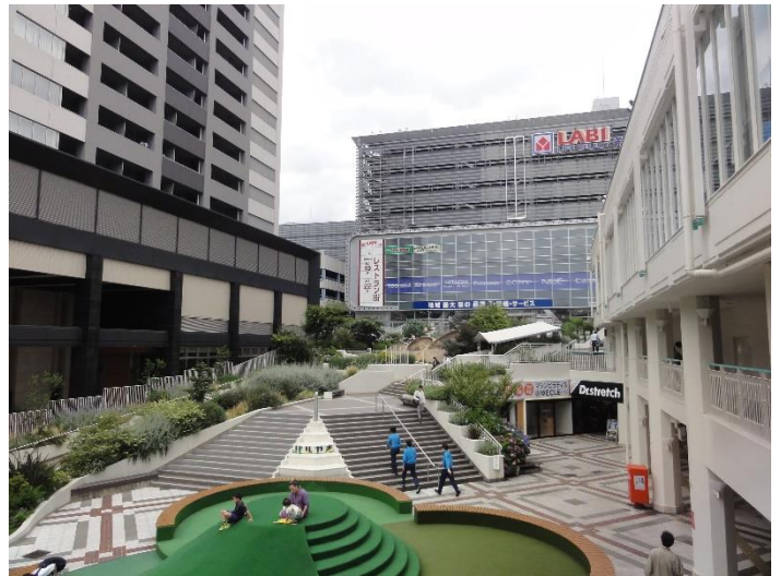
左がタワーマンション（地上50階建て）正面が家電量販店その間の地下に北急のトンネル（線路敷）が通っています右がせんちゅうパル
