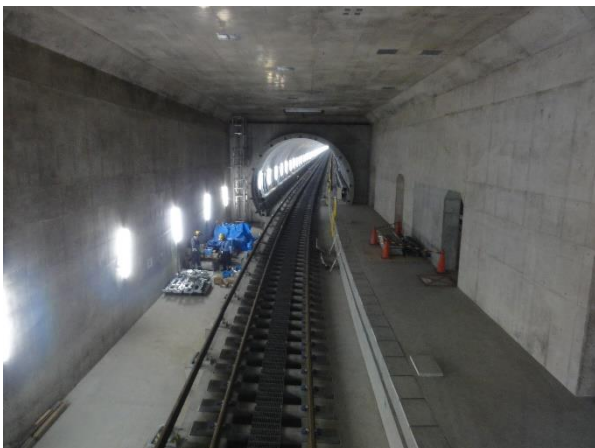
前方はシールドトンネル（地下換気所より）
