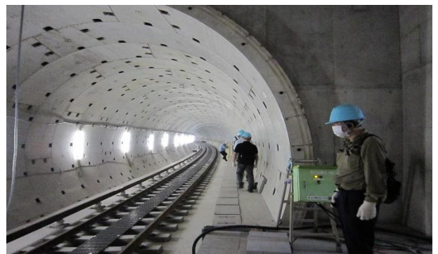
軌道敷設も終わったシールドトンネル区間
