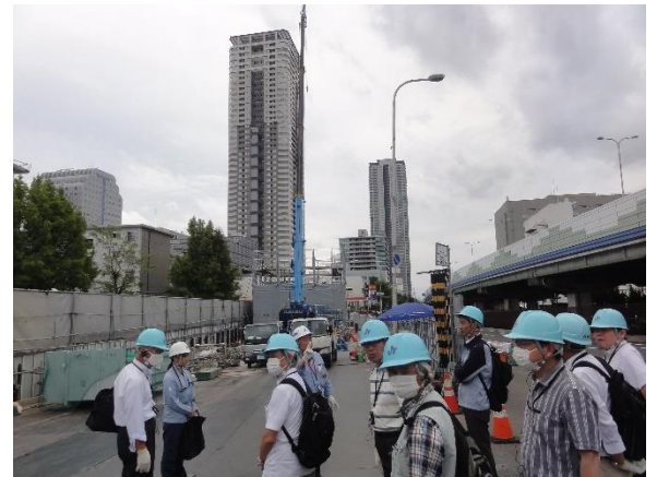
左のタワーマンション直接基礎の直近にシールドトンネルを建設（換気塔ヤードより南方面を望む）
