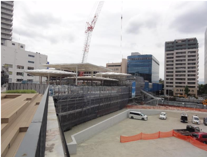
駅前広場（デッキ）、駅南側メイン出入口、歩行者デッキ 右下の空地には地権者施設（商業など）が建設予定
