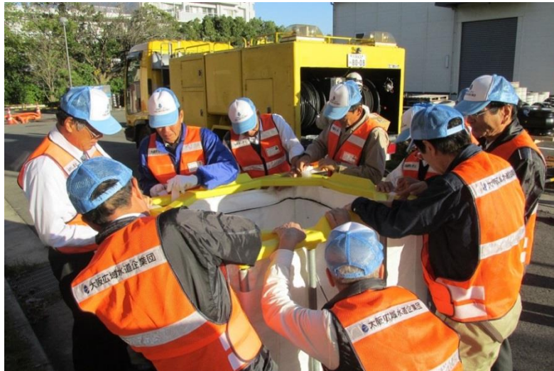
○応急給水仮設水槽の設置作業
