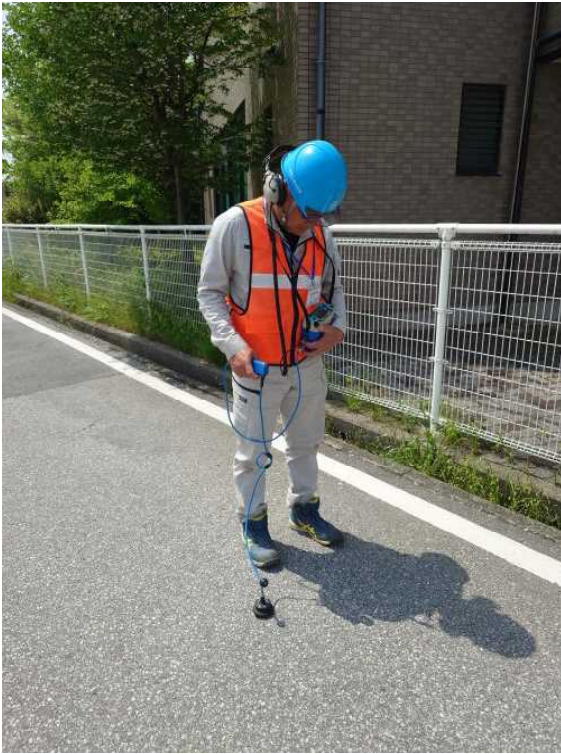
漏水探知機による調査
