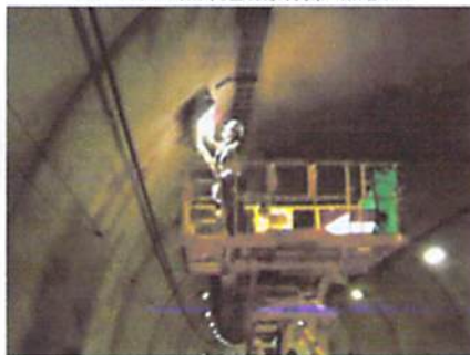
<<トンネル照明設備清掃・点検>>
