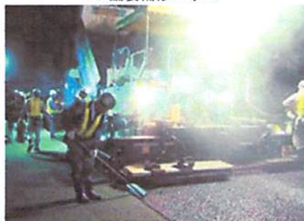
<<舗装補修工事>>
