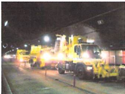
<<トンネル側壁清掃>>
