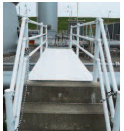
エポガードシステムを試験施 工した歩廊 © JAXA
