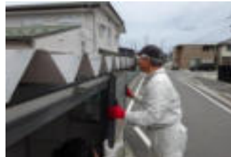
扉をレールにのせている 作業中
