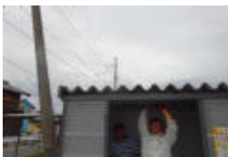
カバー取り外し作業中
