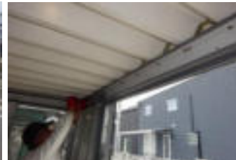
扉カバーを取り付け 作業中
