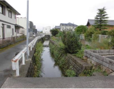
山賀川作業前
