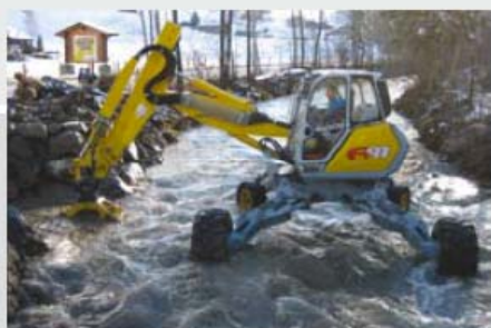
水路中のグラップル作業
