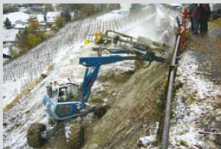
斜面工事のドリル作業
