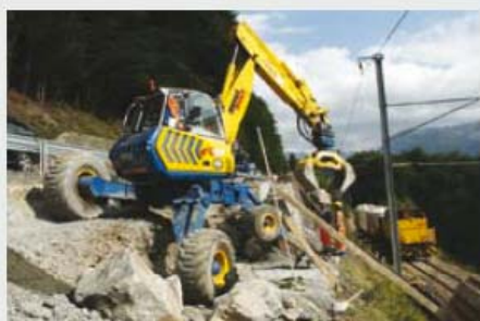
急斜面での道路建設
