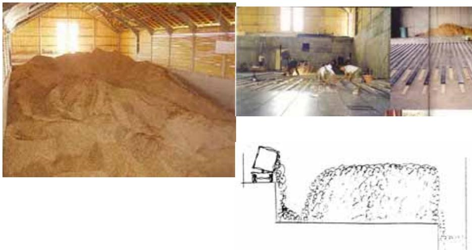
オーストリア・シェンケンフェルデン村のバイオマス地域集中暖房装置のチップ貯蔵庫兼乾燥室兼供給装置です。下のイメージ図のようにチップを投入すると、床の仕掛けで少しずつ移動し数ヶ月かかってボイラー投入溝に入るようになっていきます。この間に乾燥してしまうわけです。菌塵も発生しますが、中に人が入って仕事をするわけではありませので、問題は生じません。
