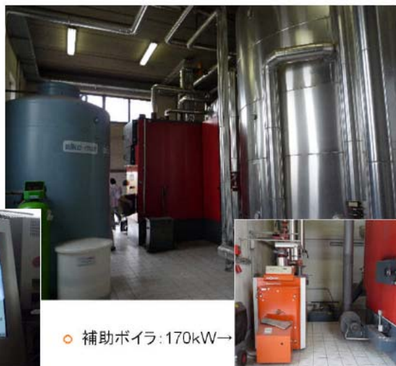
図 30 チップ保管庫反対側のボイラー室 大容量の温水タンクのお陰で、補助ボイラーはほとんど使われることがない。
