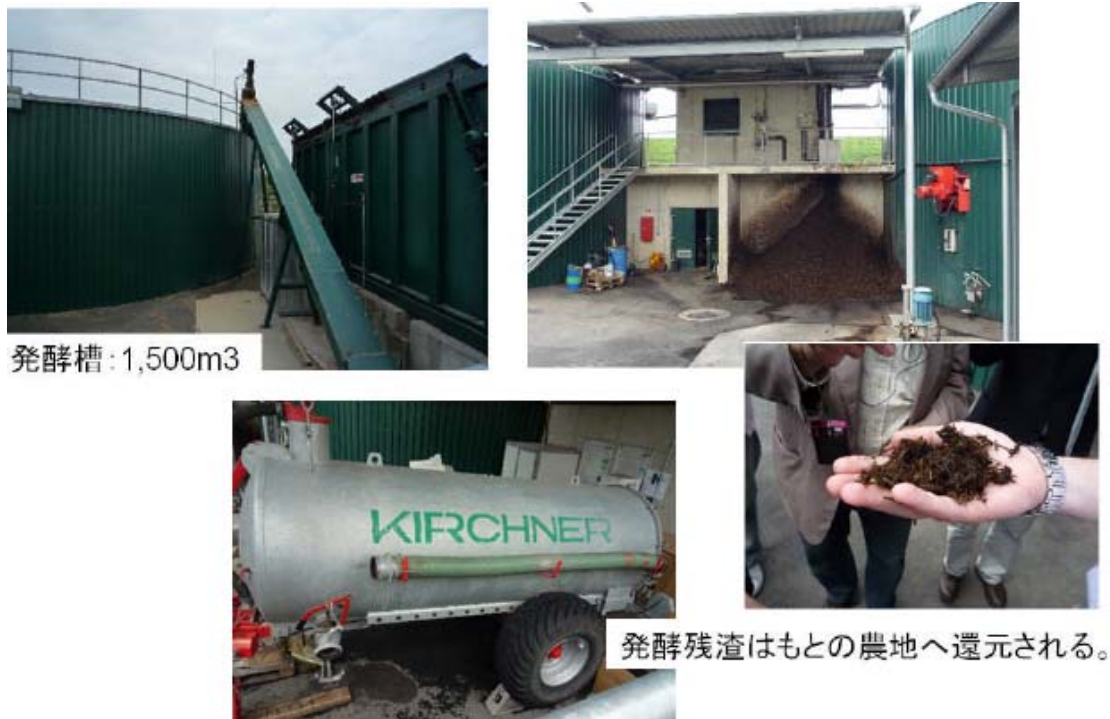
図 34 発酵槽と残渣処理
