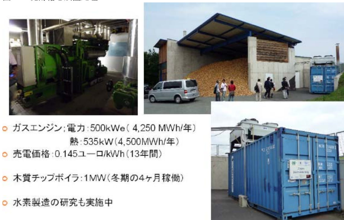
図 35 ガスエンジン、チップボイラー、右は水素製造研究棟 ここでは水素製造の研究も行われている。
