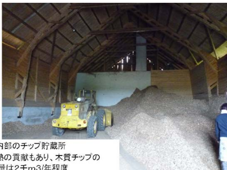
図 29 チップ保管庫内部 週に1回くらいタイヤローダで右奥のチップ送りスクレーパー溝にチップを掻き寄せる必要がある。奥の仕切り壁の向こう側がボイラー室である。
