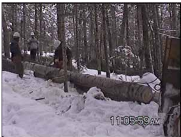
写真-6 造材作業
