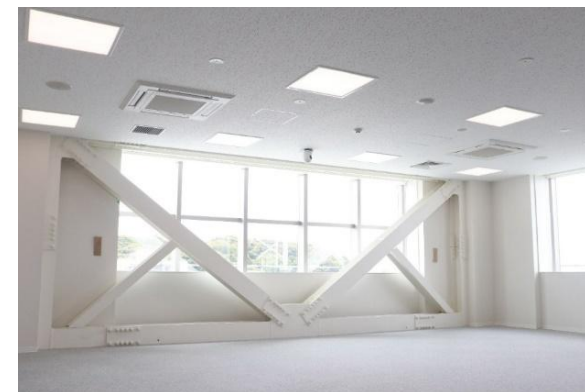
柱付き鉄骨ブレース補強
