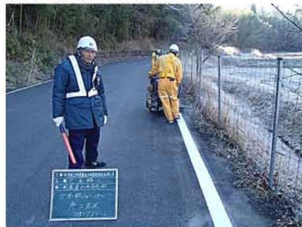
2.路面標示施工技能士に頼れば(ガードマンさんが目線)
