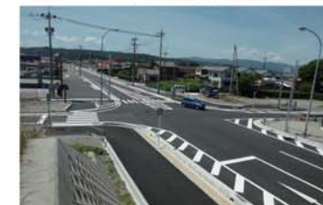
市道平井薬園1号線道路改良事業 (新旭地域)
