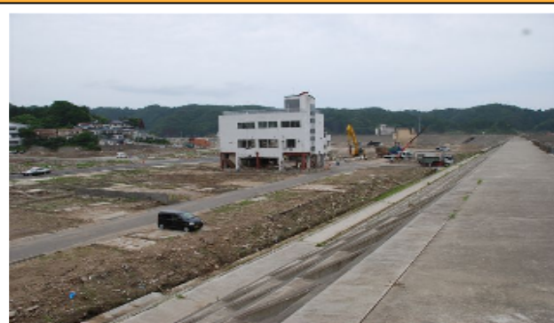
宮古市、田老地区では津波が10mの防潮堤を 乗り越え高台の一部の建物が残っただけでした
