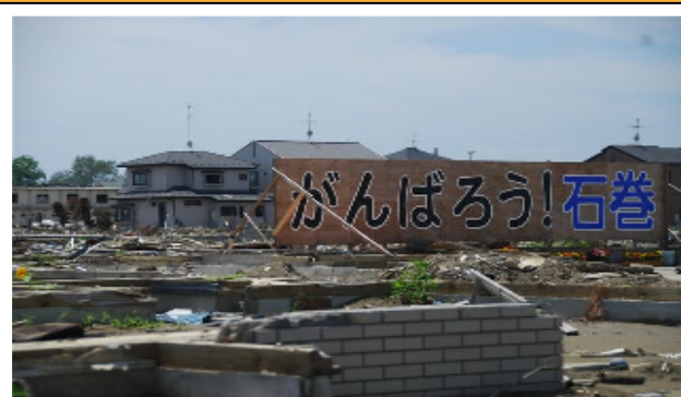
宮城県石巻地域で前を向いて進もうとされています
