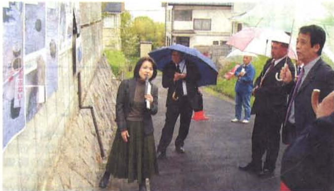
道路の陥没した現場で、議員や市役所、大津地方法務局の職員らに説明する杉原さん(左)(4月27日、大津市和邇北浜の住吉台地区で)
