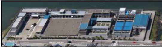
長浜水道企業団 下坂浜浄水場
