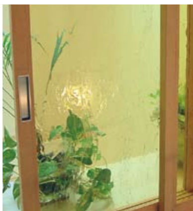
→建て主自ら手配したフランスからの輸入ガラス。それを建具屋さんで現場で手渡し、吹き抜けに面する窓に使ってもらった。
