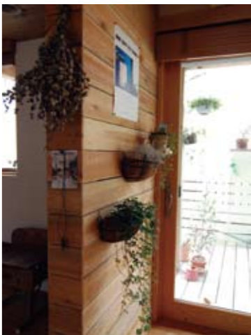
輸入木材の梱包に使われていたパレットの木材を解体して、内装壁に再利用。建て主のアイデアと大工さんの柔軟な対応に驚きました。それが今ではこのお宅のアクセントになっています。
